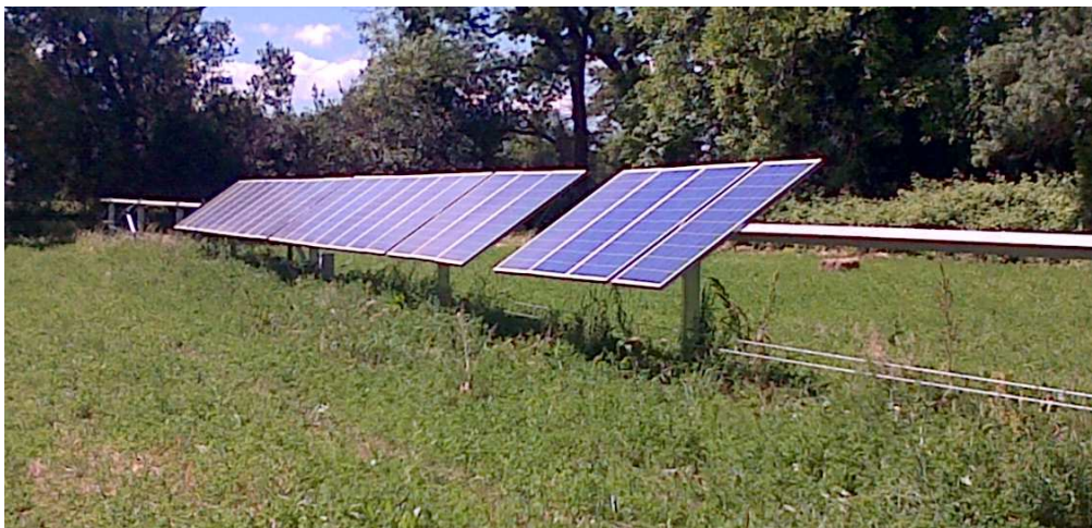
Figure 2 : Essais d'installation des trackers (Photo : Optimum Trackers)
